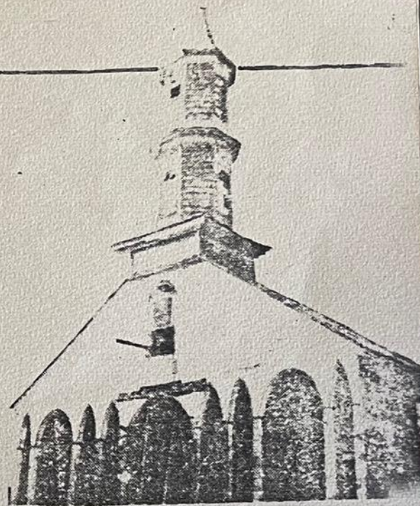
DALCAHUE.— Se han iniciado los trabajos de reparación de la torre de la iglesia de Dalcahue y de restauración de la de Achao, ambos monumentos nacionales.
